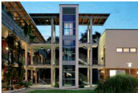
Bild 2.29: Blick zum Aufzugsturm
