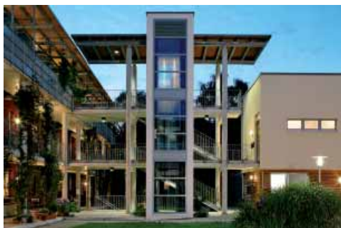
Bild 2.29: Blick zum Aufzugsturm
